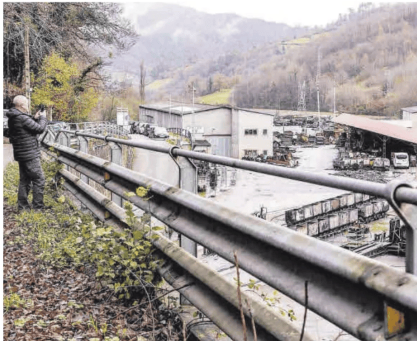
Instalaciones del pozo Nicolasa.
